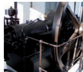
Korrózióvédelemmel ellátott régi szivattyú
