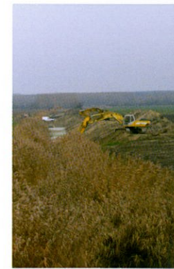
Solti-árapasztó csatorna kotrása
