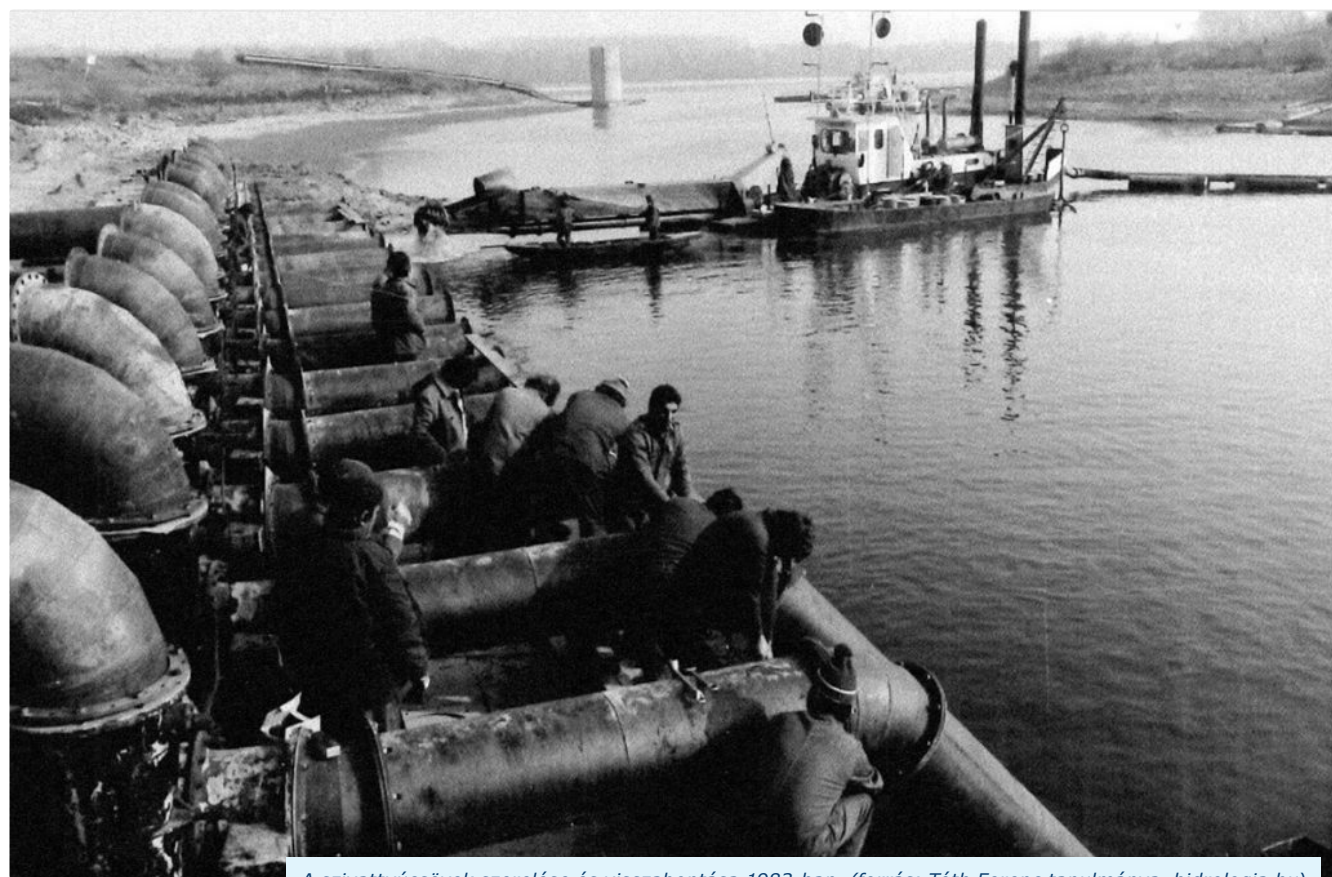
A szivattyúcsövek szerelése és visszabontása 1983-ban. (forrás: Tóth Ferenc tanulmánya, hidrologia.hu)
