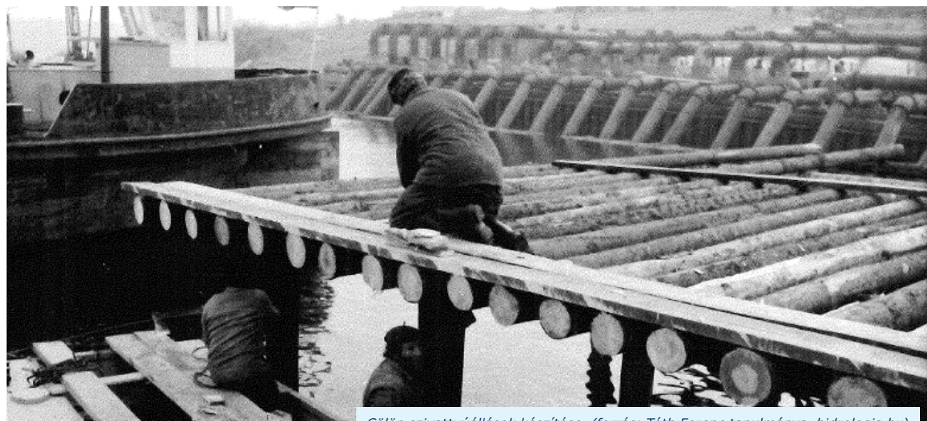
Cölöp szivattyúállások készítése. (forrás: Tóth Ferenc tanulmánya, hidrologia.hu)
