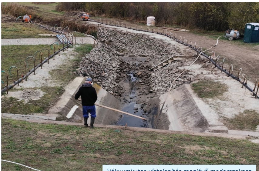
Vákuumkutas víztelenítés meglévő mederszakasz
