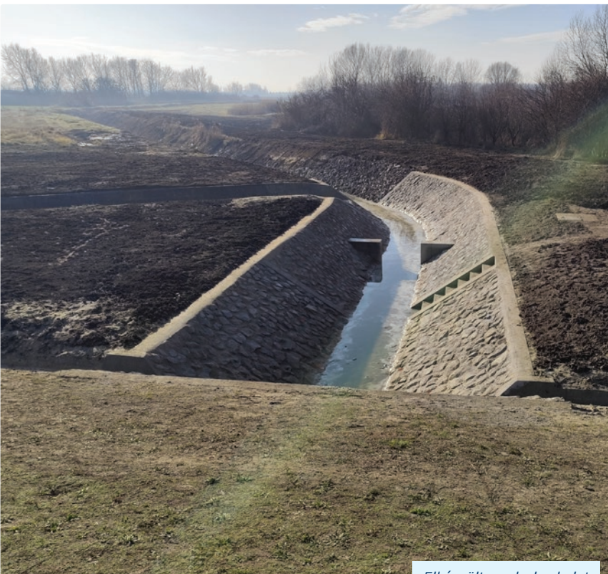
Elkészült mederburkolat
