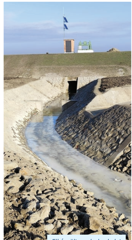
Elkészült mederburkolat
