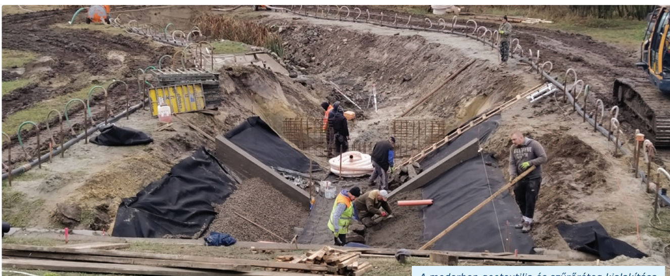
A mederben geotextília és szűrőréteg kialakítása
