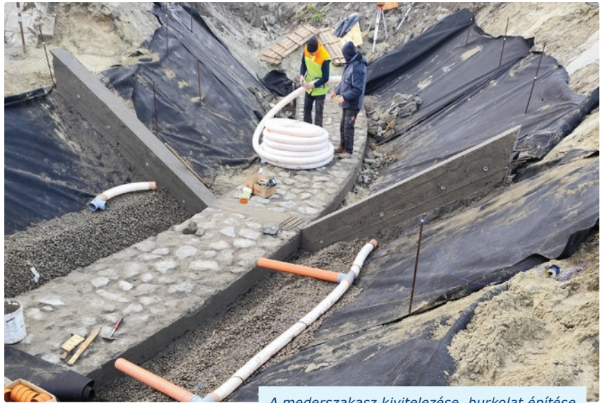
A mederszakasz kivitelezése, burkolat építése
